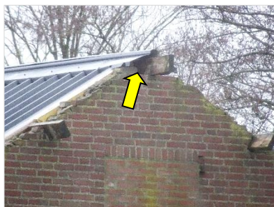
Figuur 5.2 Geschikte nestlocatie voor kerk- en steenuil in westelijke schuur.
