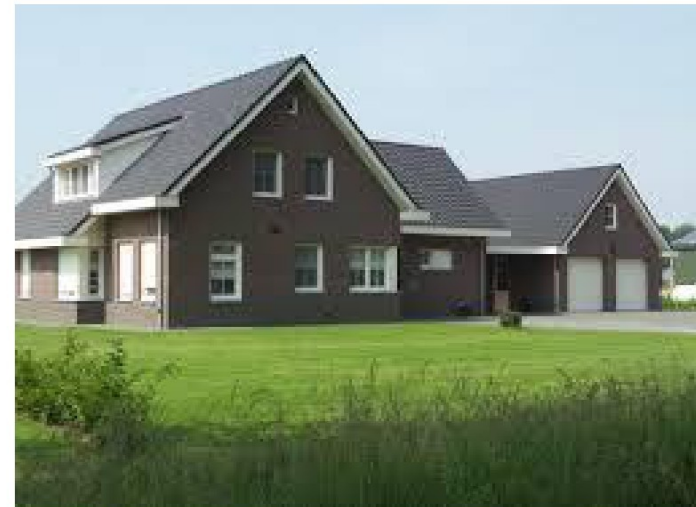
beperkte geleding, ruime dakoverstekken
