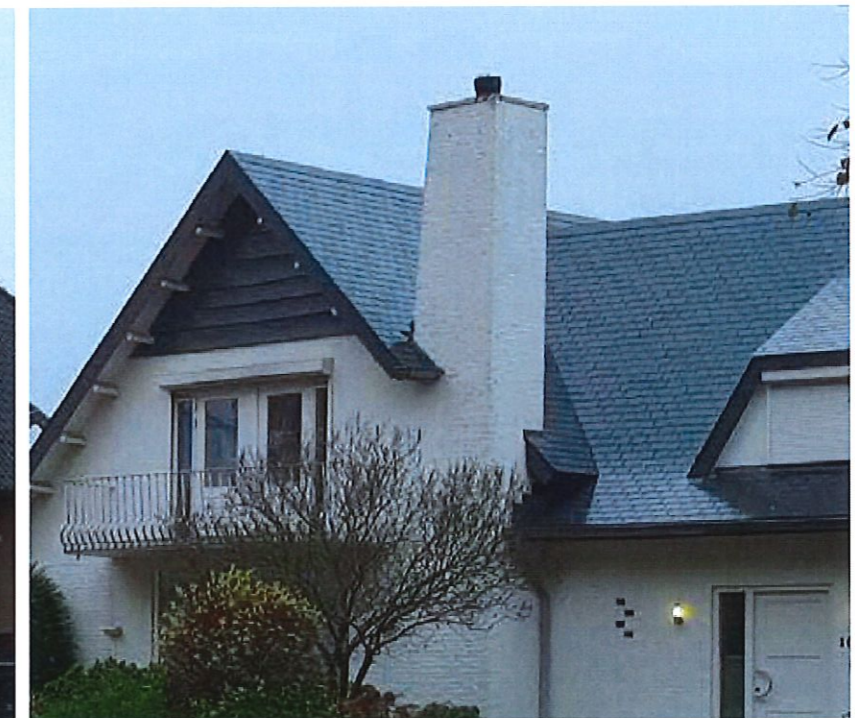
Woningen voorzien van een schoorsteen
