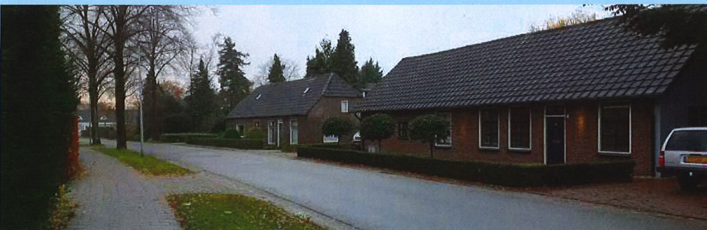
Enkele woningen staan direct aan de straat
