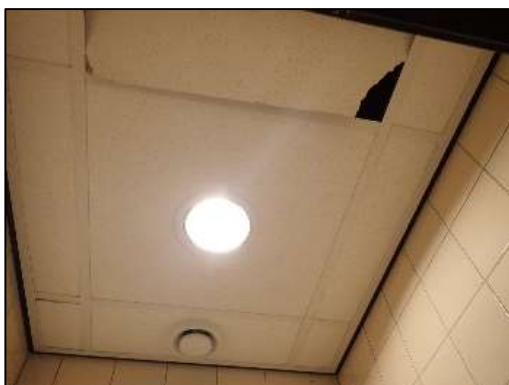
Beschadiging systeemplafond
