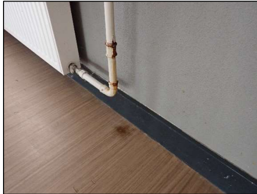
Corrosie leidingwerk
