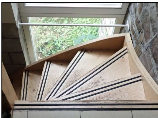
Slijtagesporen lakwerk houten trap
