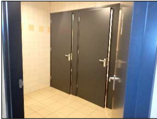
Houten kozijnen toiletten
