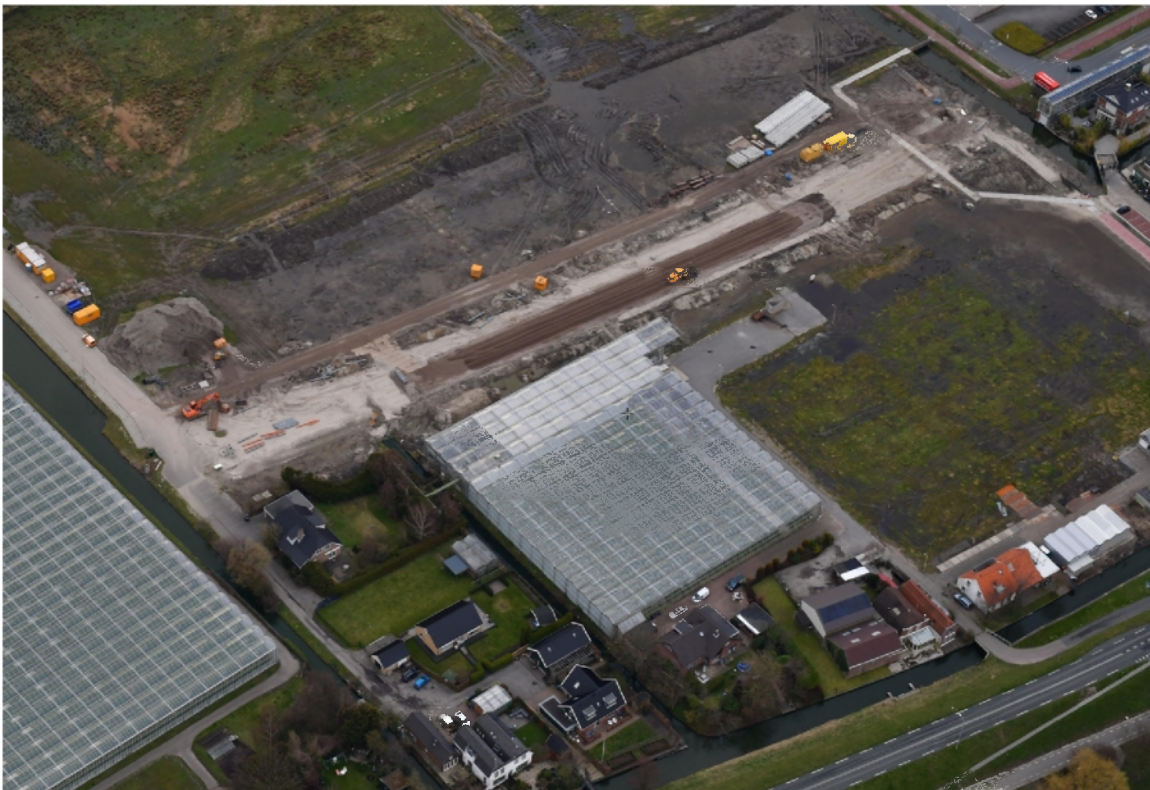
Uitsnede obliek Oost (03-04-2018), bestaande situatie perceel.
