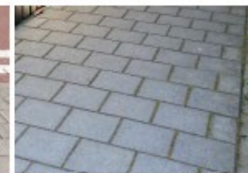
Trottoir (betontegels, grijs, halfsteensverband)
