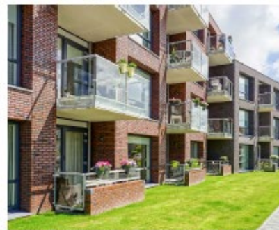
Inpandige buitenruimte afgeschermd met lage gemetselde muur
