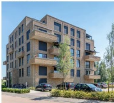
Balkons voorzien van metselwerk
