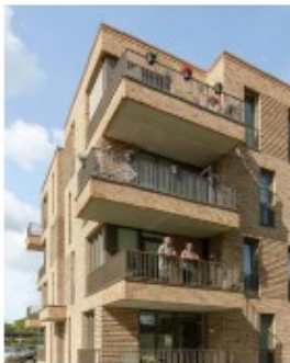
Balkons metselwerk en hekwerk
