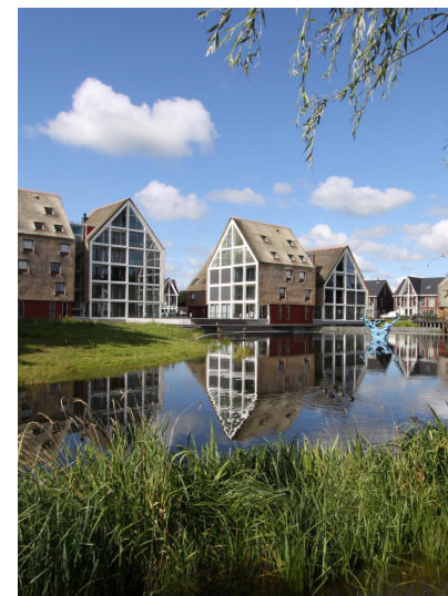
Geleding in gevelopbouw
