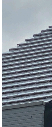
Pannendak mogelijk in kleur van gevel
