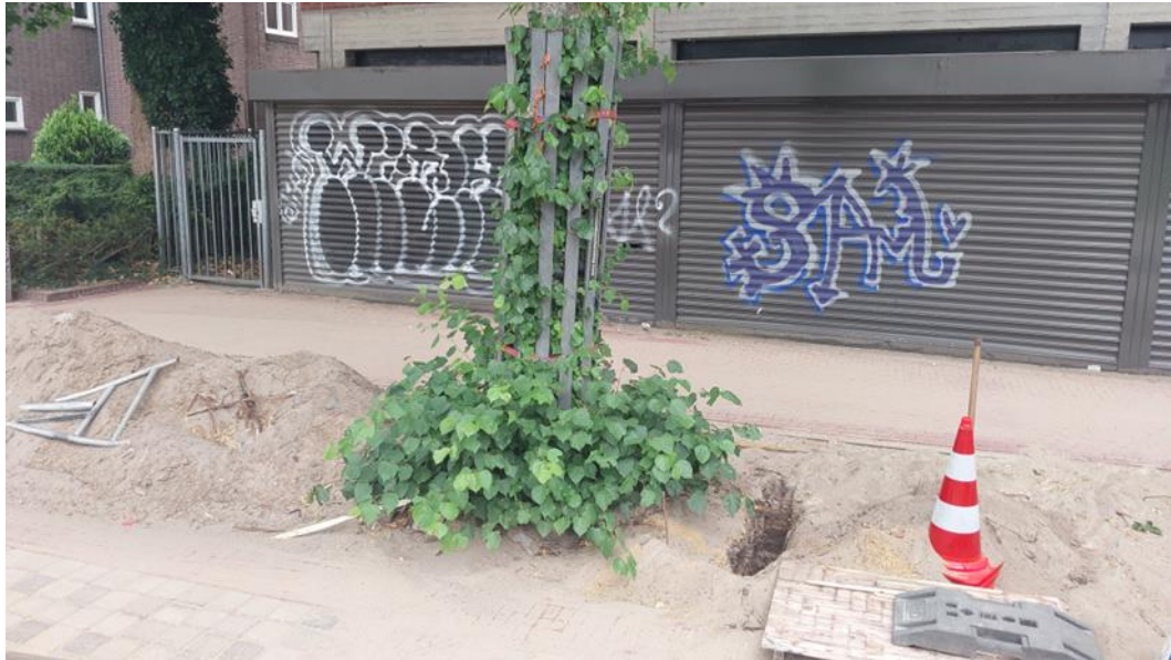
Foto 9. Overzichtfoto groeiplaatsonderzoek 2 bij boom 2
