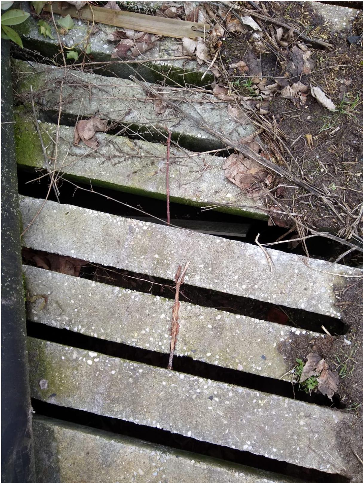
Figuur 11. Aanwezige mestkelder ter hoogte van Runstraat 7a.
