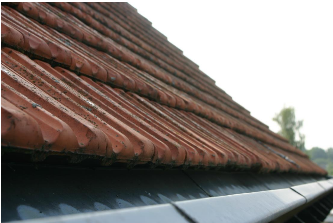
Figuur 4.2.2. Onder de onderste rij dakpannen op de woning is geen ruimte voor vogels.
