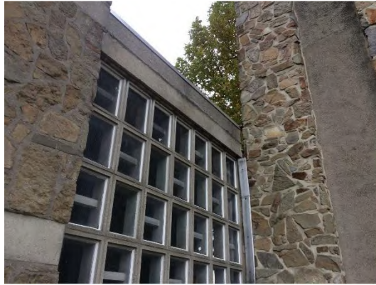
Figuur 8: Aluminium daktrim bij plat dak zuidelijk deel van het kerkgebouw.
