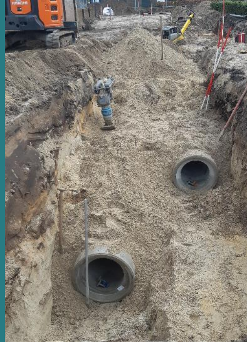
Rioolvervanging Steensel: een buis voor afvalwater en een buis voor regenwater
