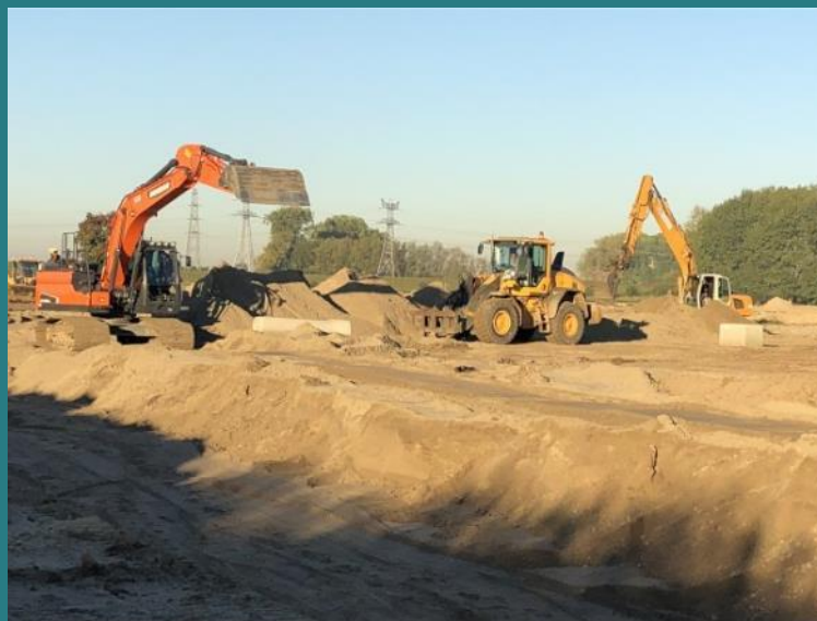
Ophogen voor nieuwbouw Bron: waalsprong.nl
