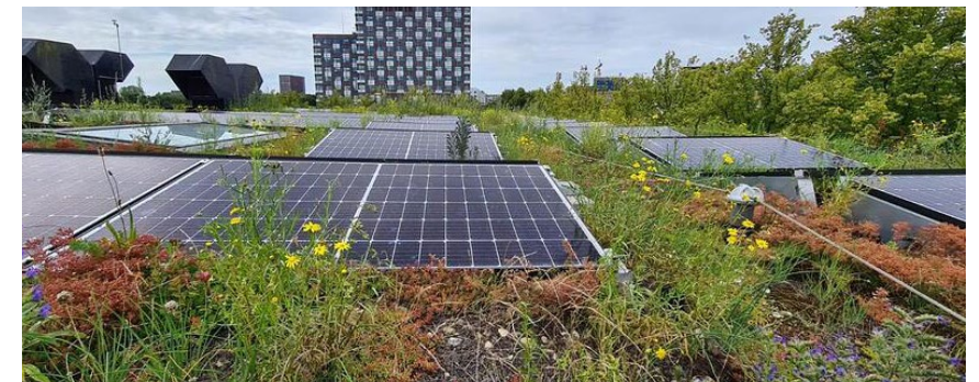
Figuur 64: Groendak (kruidendak) met zonnepanelen
