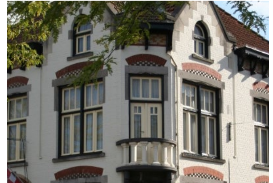
Figuur 7: Karakteristiek gebouw aan de buitenste schil
