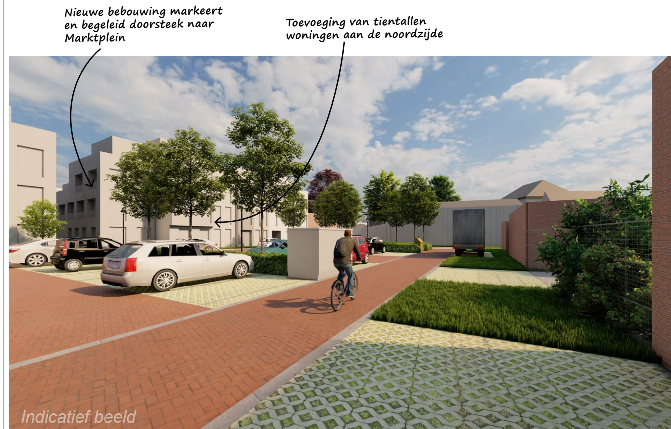
Zicht vanuit de zuidzijde richting het noordoosten Fase 2 - aan de noordzijde zijn de eerste bouwprojecten gerealiseerd
