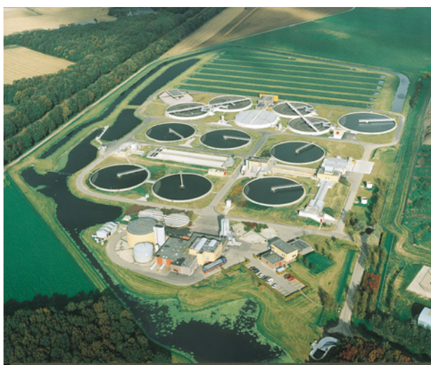
Figuur 10: (foto) Riolwaterzuiveringsinstallatie Land van Cuijk
