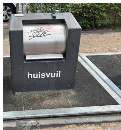
Door het legen van de container is de rand gedeukt, waardoor hij niet goed meer aansluit. Dit zorgt voor onveiligheid, omdat mensen erover struikelen.
