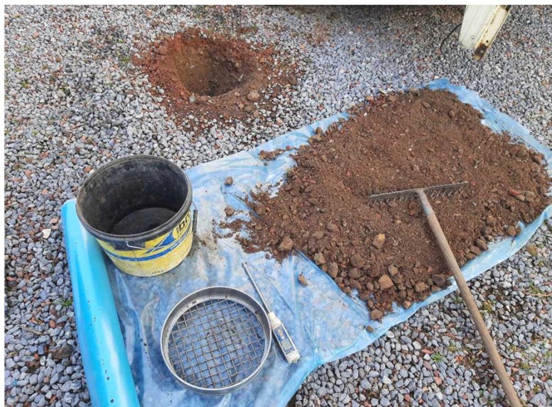
asbest-onderzoek Bazeldijk, april 2022
