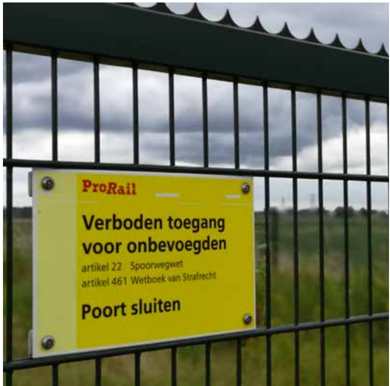
PLANGEBIED LIGT GROTENDEELS TUSSEN TWEE SPOORLIJNEN. DEZE ZIJN NIET TOEGANKELIJK D.M.V. HEKWERKEN.
