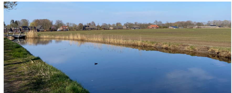
Afleidingskanaal: afwateringskanaal buiten functie, onderdeel van Aa-watersysteem
