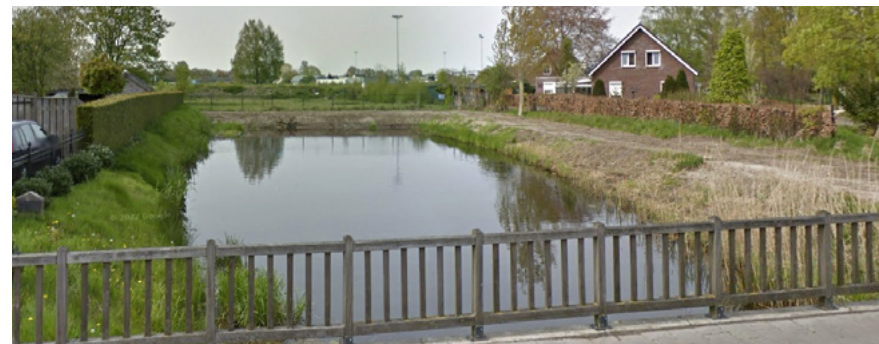
Afleidingskanaal, water staat met duiker in verbinding met de Blauwe Poort
