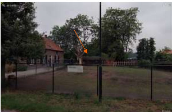
Foto 14: schuurtje met asbestverdacht dak op perceel van Burgt 8
