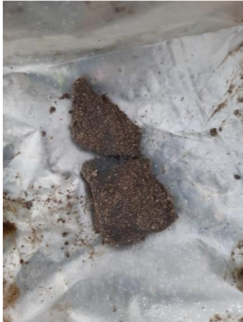
Omschrijving: asbestverdacht materiaal meetpunt 201
