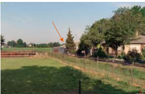
Foto 4: schuur met asbestverdacht dak op het perceel van Bovenstehuis 3
