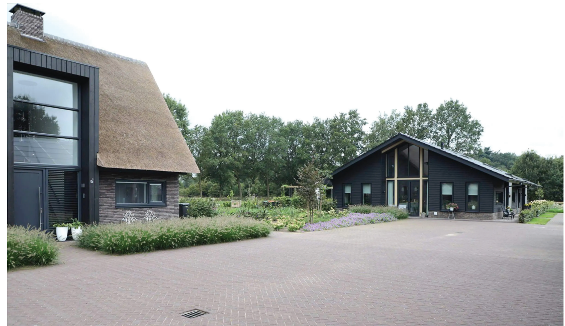
Informeel erf met grijze klinkerverharding
