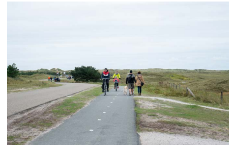
smalle fietspaden i.c.m. ontbreken voetpaden
