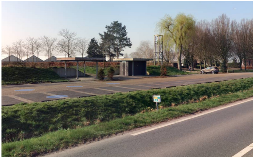
19: Zicht op parkeerterrein vanaf provinciale weg.
