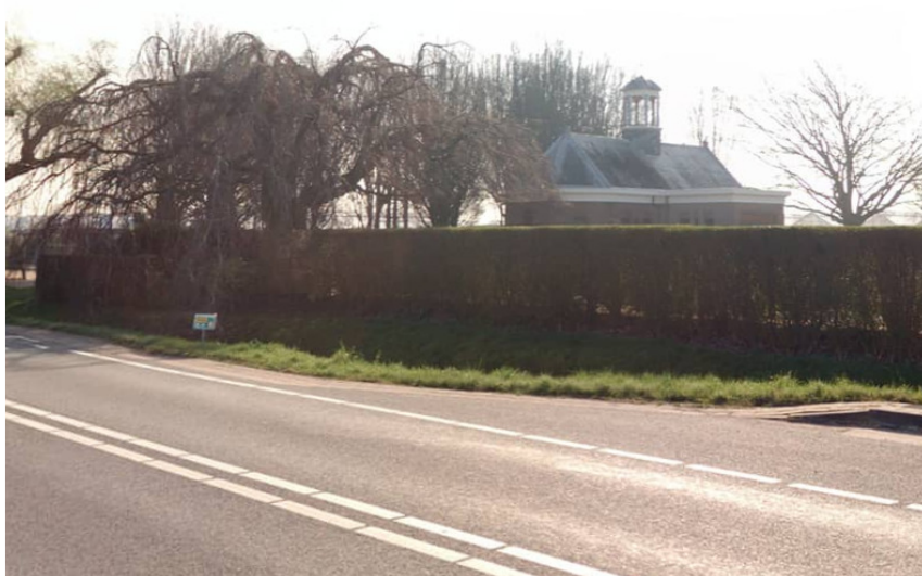
18: Zicht op oude gedeelte vanaf provinciale weg
