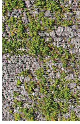
souterrain: schanskorf, gevuld met puin boerderij: natuurinclusief en circulair
