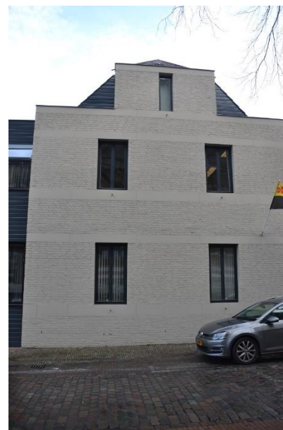
Het tweede geveldeel, daterend uit de bouwtijd.
