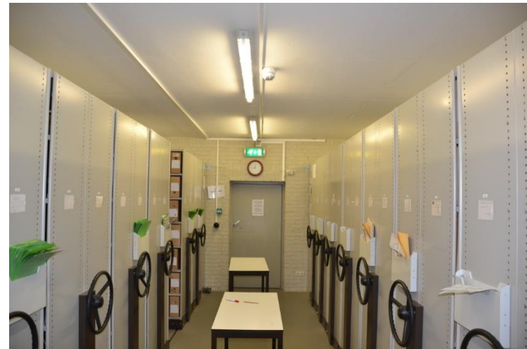
De muur met deur tussen 00.02 en 00.03 vanuit 00.03 gezien.
