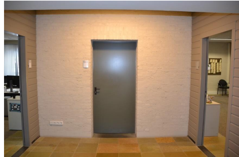
Nieuwe gevel met toegang tot 0.17.
