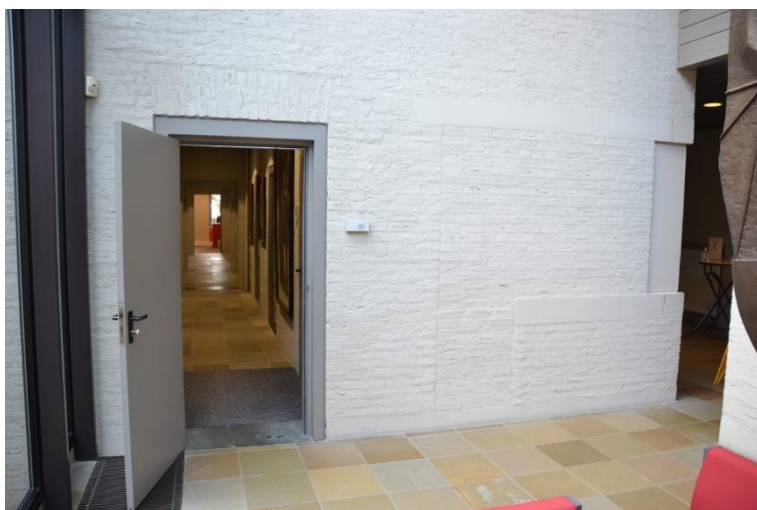
Hetzelfde gevelvlak vanuit een andere hoek gezien met rechts het restant van de vm. receptie duidelijk herkenbaar.
