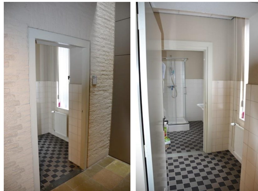
Links en rechts: ruimte 0.37 (toilet en douche). Indeling is oorspronkelijk. De afwerkingen dateren van na de bouwtijd.
