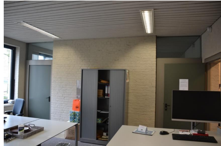
Scheidingsmuur met 0.47 en de twee tussendeuren.
