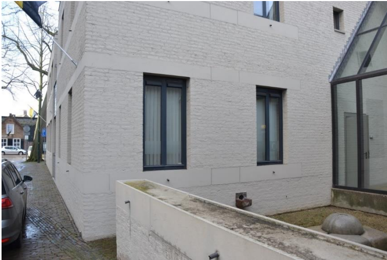
De linker gevel aan de binnenplaats t.h.v. de begane grond.
