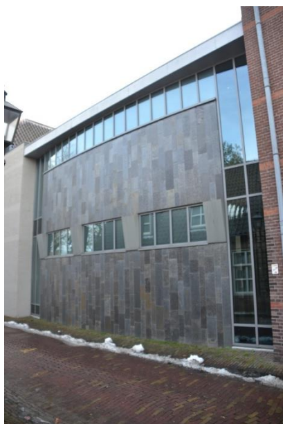
Detail van de gevel uit 2001.
