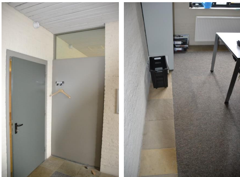
Links: toegangsdeur 1.30 met rechts daarvan tussendeur naar 1.36. Rechts: detail van de vloerafwerking.
