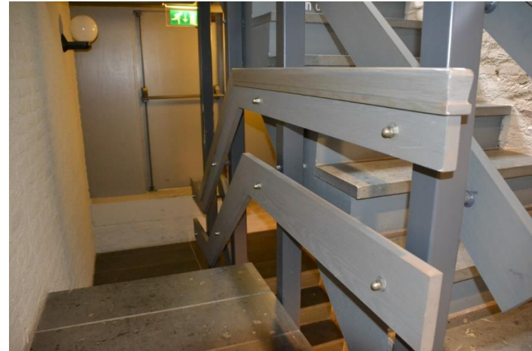
Detail van de balustrade van de bordestrap.
