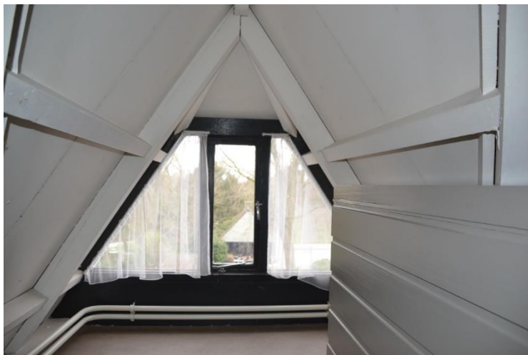
Ruimte 2.20: rechts balustrade van trapopgang. Midden een van de dakkapellen.
