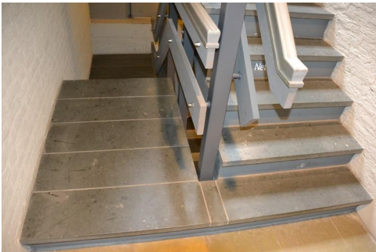
Detail van het trappenhuis met hardstenen basement.
