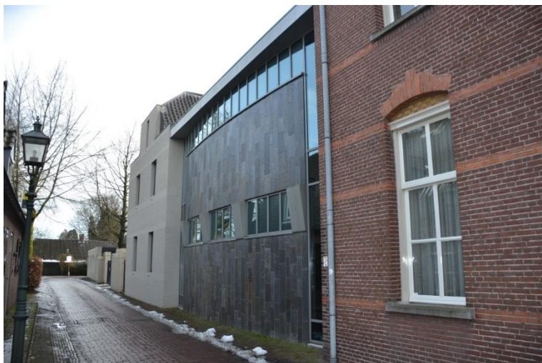
Van rechts naar links: kantongerecht; gevel uit 2001; gevel uit 1979.
