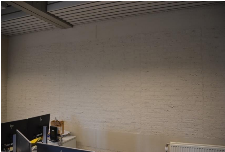
Bouwsporen in de vm. buitengevel van vensteropeningen.
