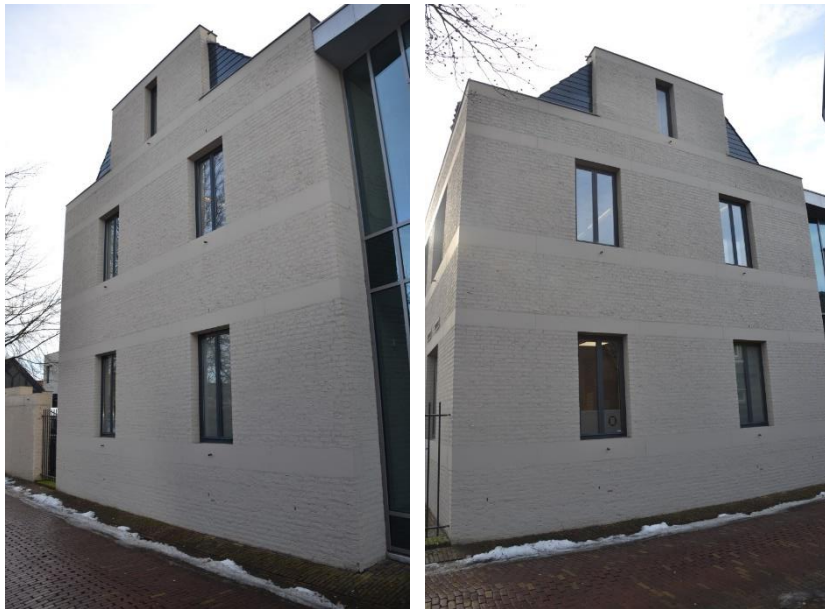
Links en rechts: de gevel in Bossche School architectuur als onderdeel van het oorspronkelijke gemeentehuis.
