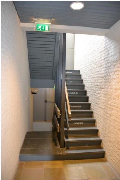
Trappenhuis met houten bordestrap. Daarachter een nooduitgang.
