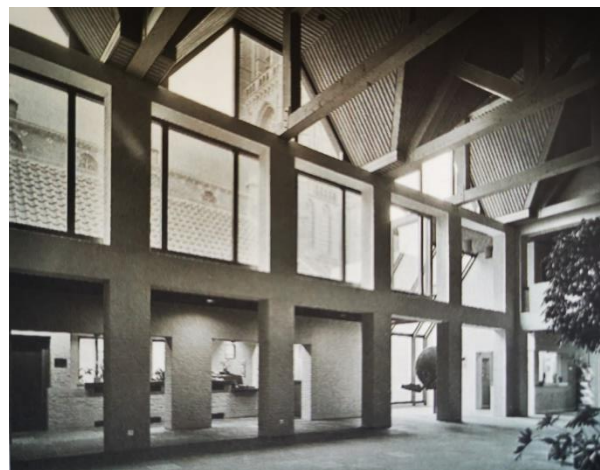
De centrale hal vlak na oplevering in 1982. Bron: H. de Haan en I. Haagsma, Gebouwen van het Plastische Getal. Een lexicon van de 'Bossche School' (Haarlem 2010), p. 167.
