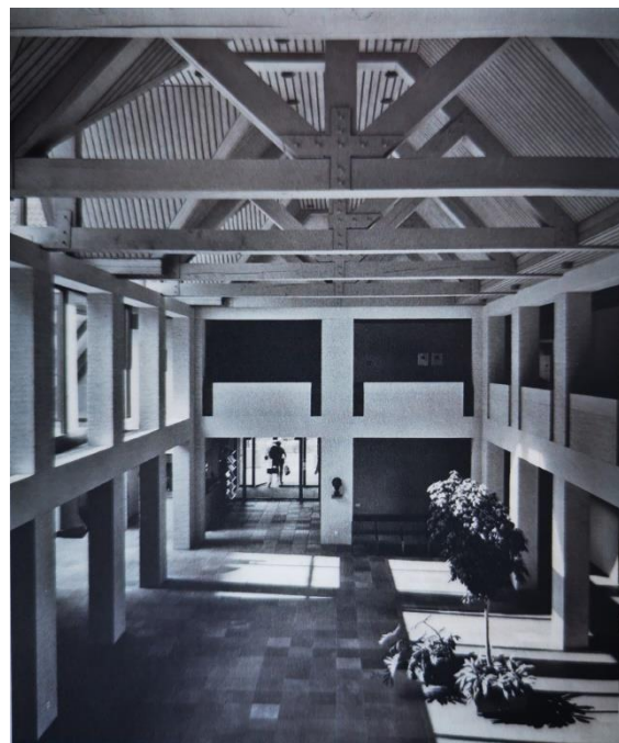
De centrale hal vlak na oplevering in 1982. Bron: H. de Haan en I. Haagsma, Gebouwen van het Plastische Getal. Een lexicon van de 'Bossche School' (Haarlem 2010), p. 167.
