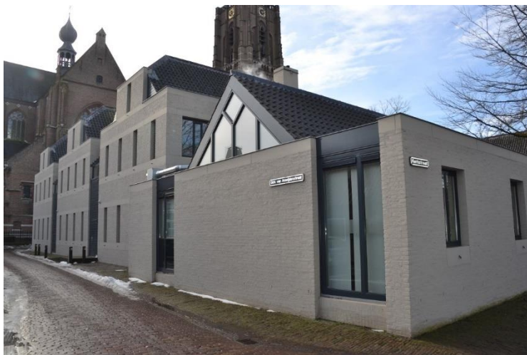
De gevel aan de Dirk van Ameijdenstraat met een duidelijk onderscheid tussen de Bossche School architectuur en de latere eenlaagse aanbouw.
