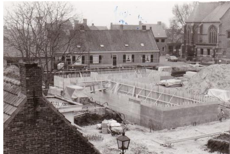
Het nieuwe gemeentehuis in aanbouw, 1980. Bron: De Heerlijkheid Oirschot, BHe_20160302_0028.
