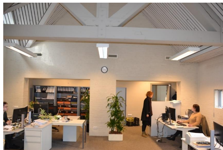
Ruimte 1.07 met sparingen in de tussenmuur, richting de galerij gezien.
