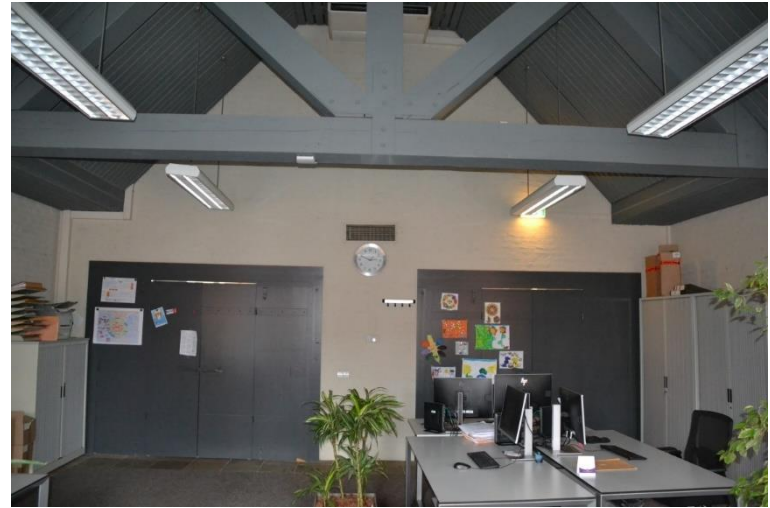
Ruimte 1.17 naar de deuren toe gezien.
