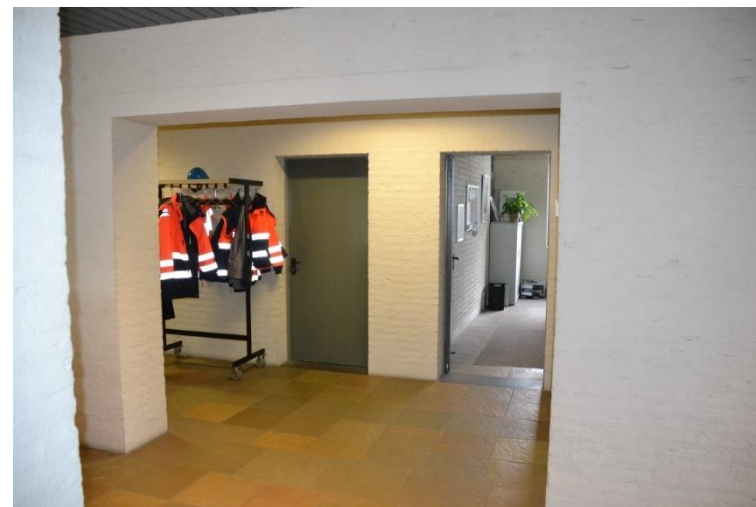
Ruimte 1.35 vanaf de galerij gezien. Rechts de open deur van 1.30. Links daarvan de deur naar 1.36.
