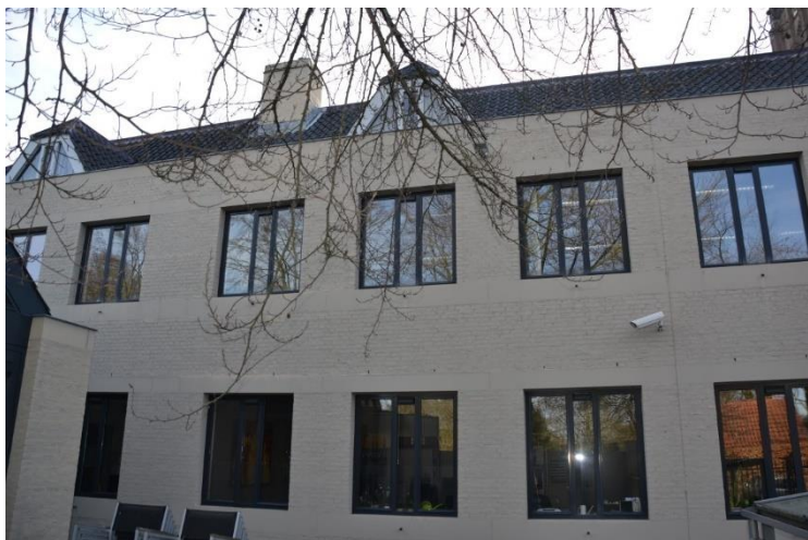
Deel van de rechterzijgevel van het oorspronkelijke gemeentehuis.
