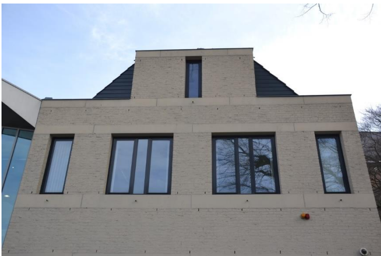
Detail van de eerste verdieping en de tuit met aan weerszijden de met meranti bekleding van de kap.
