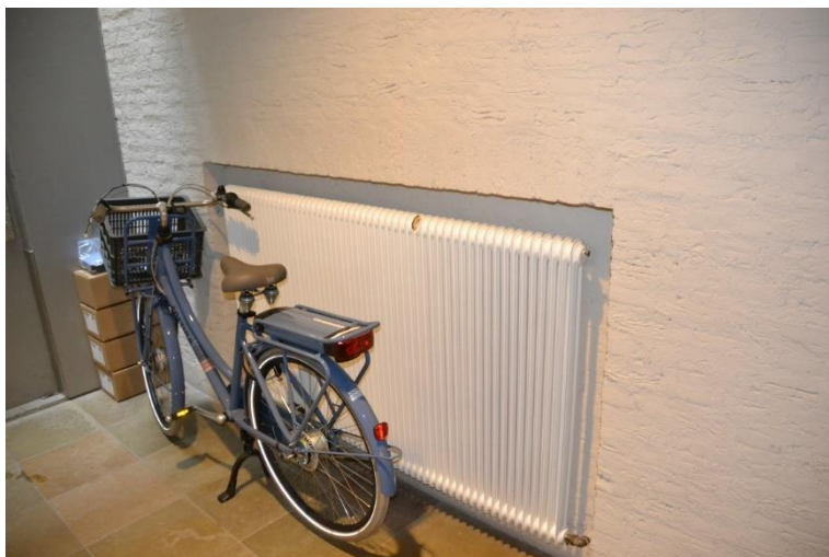
Radiator in oorspronkelijke nis.
