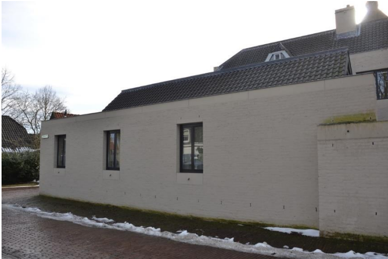
De linkerzijgevel t.h.v. de bedrijfskantine. Rechts het begin van de tuinmuur.
