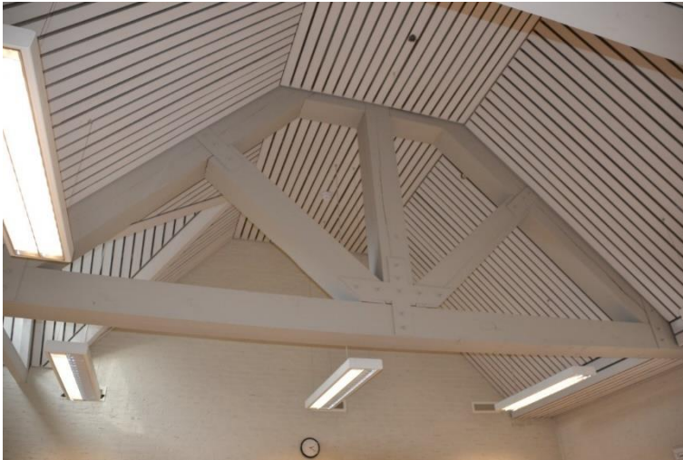
Spant en schrotenafwerking in 1.07.
