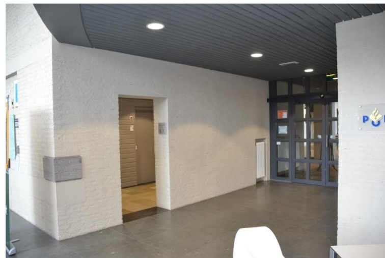
Ruimte 0.04 met links de doorgang tot ruimte 0.63.
