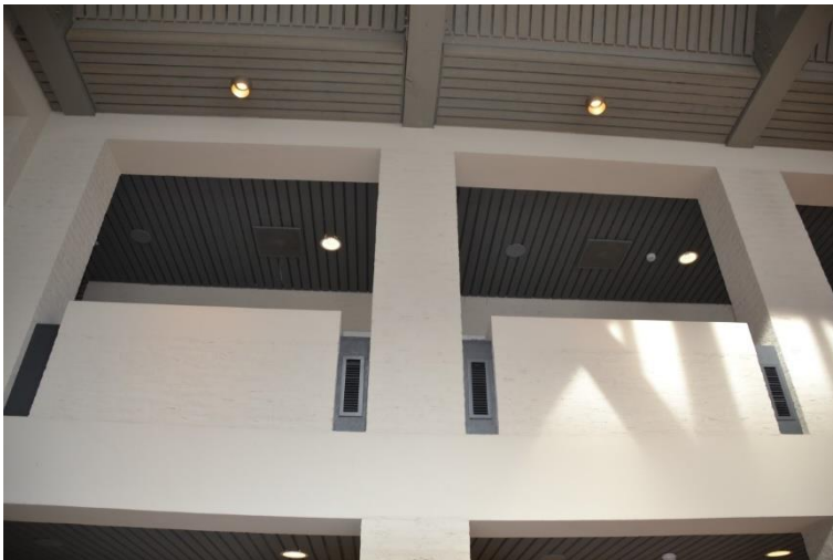
Detail van de balustrade/borstwering op de galerij.
