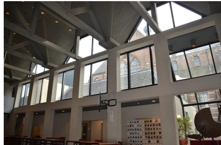
De zuidzijde van 0.64 met opengewerkte gevel vanaf de verdieping.
