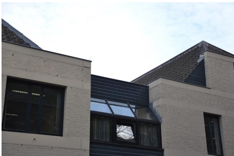
Detail van de geknikte pui in het tussenlid.
