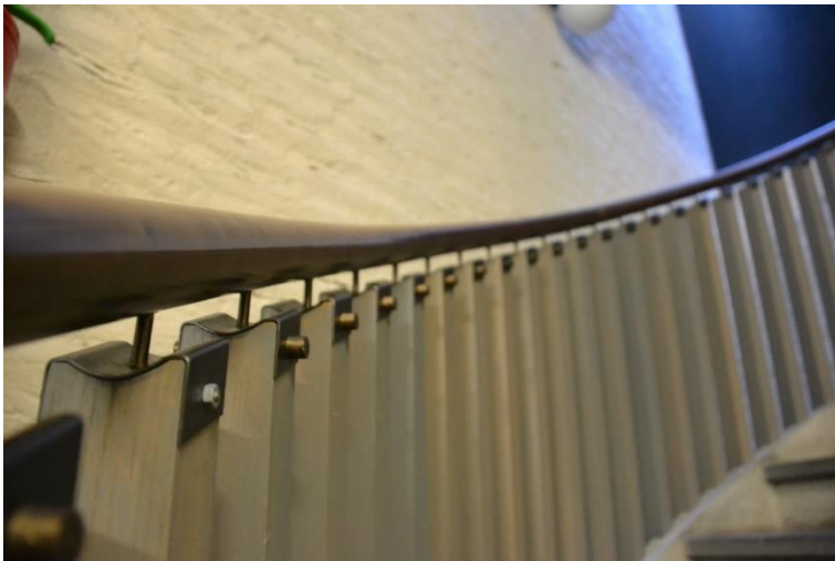
Detail van de balustrade en trapleuning.
