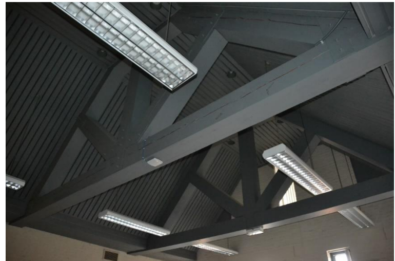
Detail van de spanten en afwerking met schroten.
