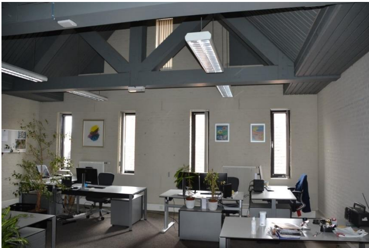
Ruimte 1.17 vanaf de deur gezien.
