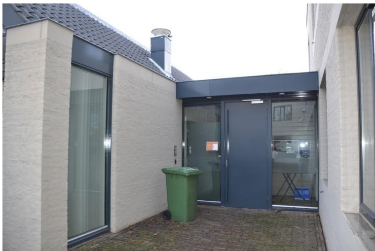
Zijgevel van de bedrijfskantine en de personeelsingang.
