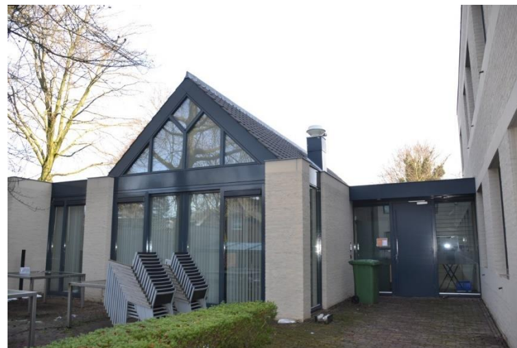
De kopgevel van de bedrijfskantine aan de zijde van het achterterrein.
