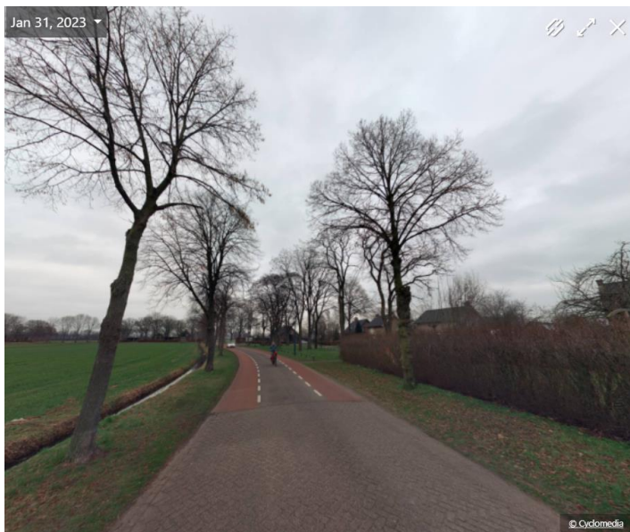
Figuur 9 Bestaand wegprofiel Nobisweg, overgang asfaltverharding / klinkerverharding (bron: Cyclomedia, 2023)
