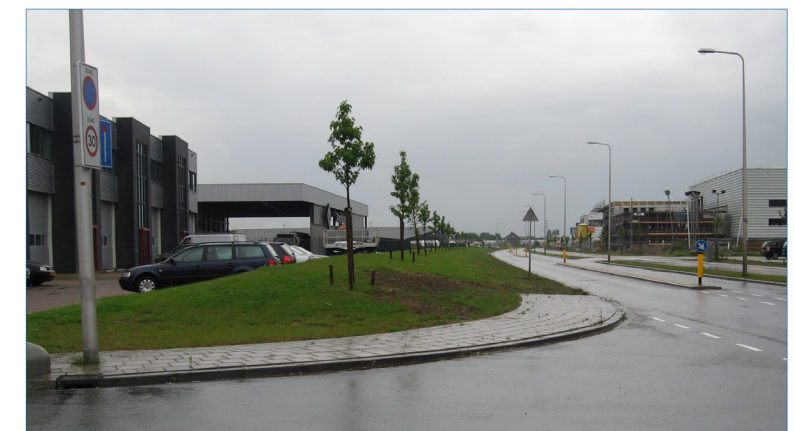
Groen talud langs de ontsluitingsweg
