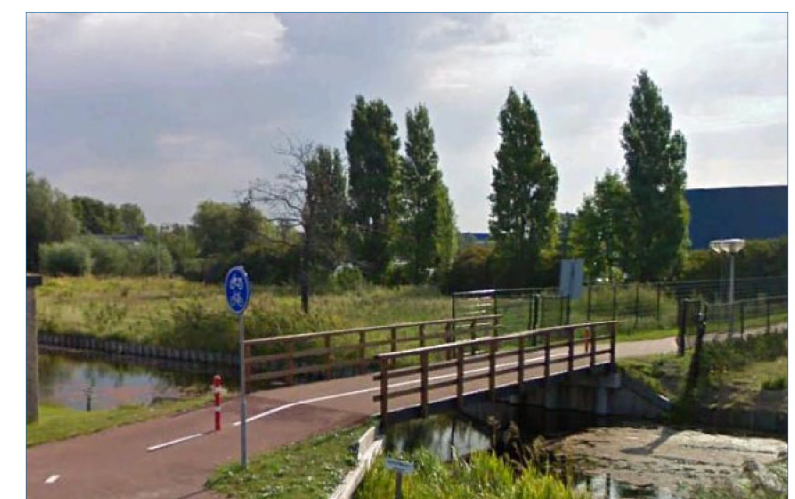
Houten fietsbrug in fase I
