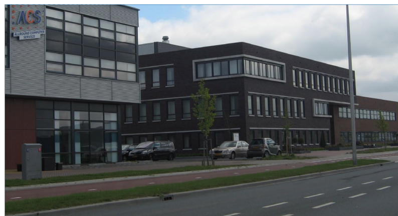
Fietspad en groen langs de centrale ontsluitingsweg
