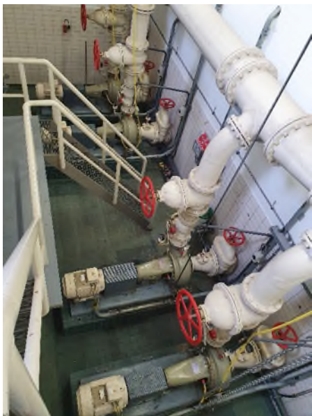
Hoofdrioolgemaal De Lange Hagel
