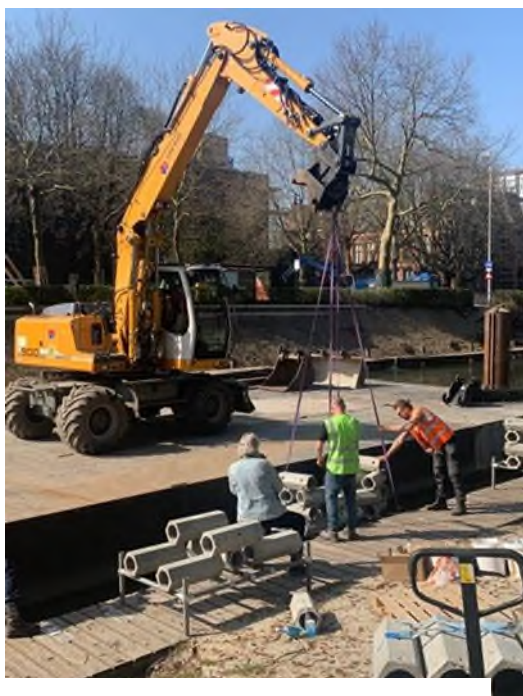
Aanleg onderwaterstructuur Catharijnesingel
