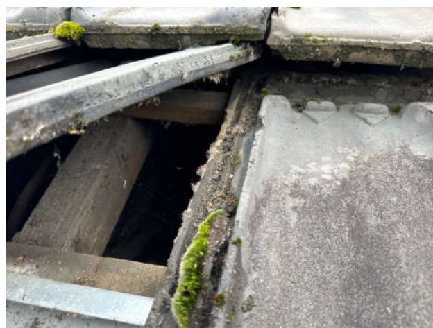
geen dakbeschot boven midden zaal
