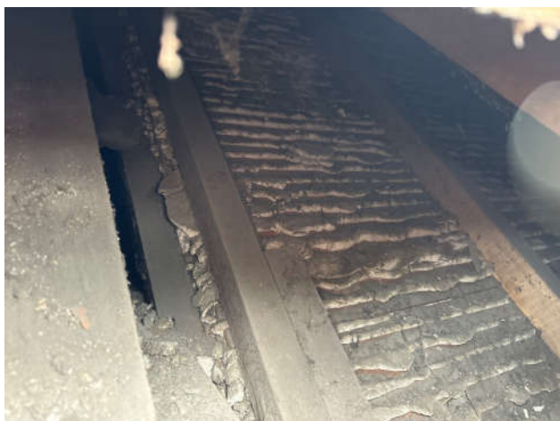
geen dakbeschot boven midden zaal
