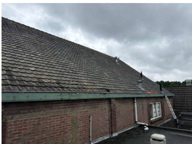
geen dakbeschot boven midden zaal
