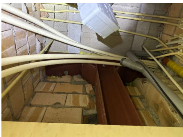
opbouw verdieping vloer
