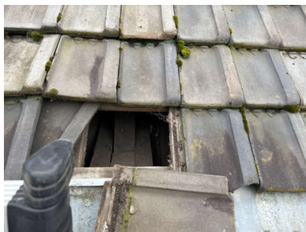
geen dakbeschot boven midden zaal
