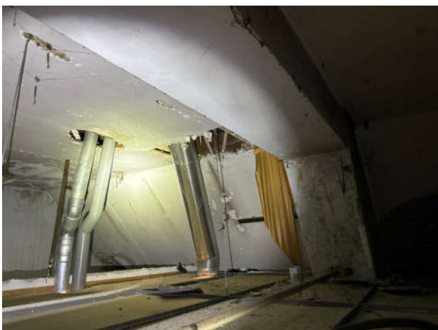
boven systeemplafond cv-ruimte achter ingang zalen
