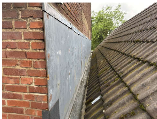
Wandbeplating achtergevel onverdacht
