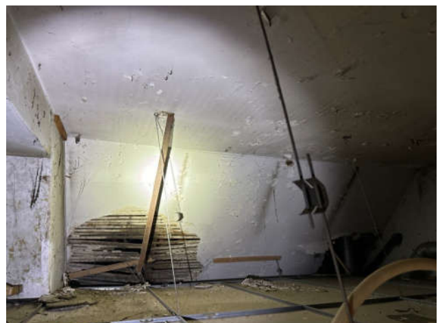
boven systeemplafond cv-ruimte achter ingang zalen
