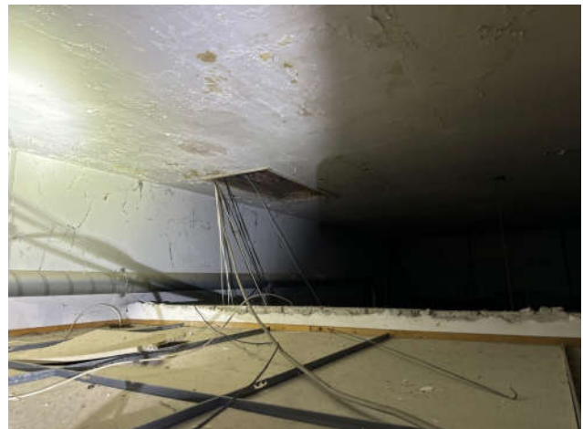
boven systeemplafond cv-ruimte achter ingang zalen
