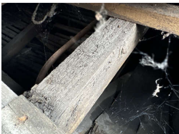
geen dakbeschot boven midden zaal
