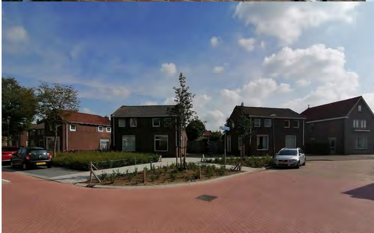
Boven: Kopgevel. Geen spouwopeningen, maar onder de kantpannen zijn openingen aanwezig. Onder: Overzichtsfoto van het zuidelijke deel van het plangebied.
