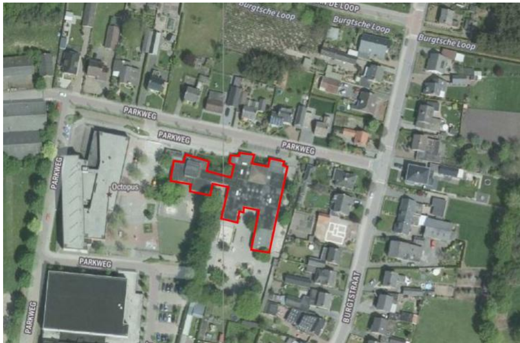
Afbeelding 1: Ligging van het te slopen schoolgebouw (rood omlijnd) aan de Parkweg te Boekel (bron luchtfoto: ESRI).
