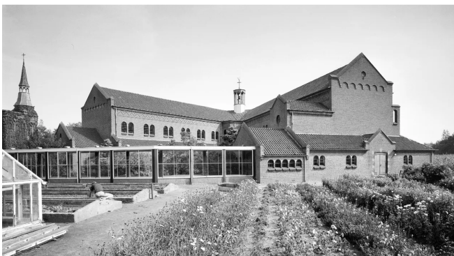
Inmiddels gesloopte klooster De Goede Herder, waar vrouwen onder dwang werden opgevangen en te werk gesteld (ca 1955-1975).
