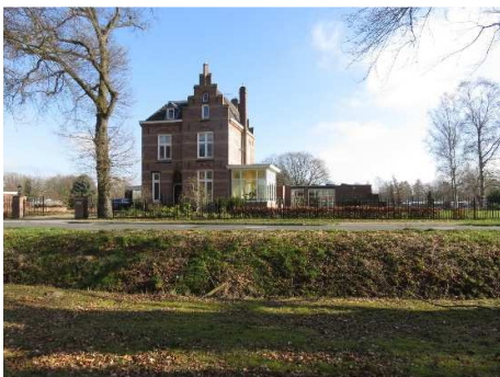
Het Rectorshuis hoorde bij het klooster de Goede Herder, en is recent geheel gerestaureerd. Het is een belangrijk landmark aan de hier al landelijke Vriezenveenseweg.
