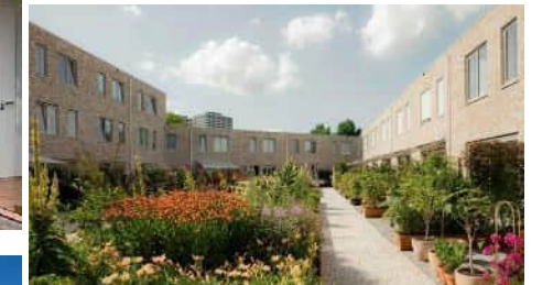
Buizenruimte aan een collectieve tuin
