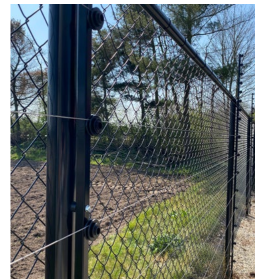
02. bestaand beveiligingsraster met bewegingsdetectie
