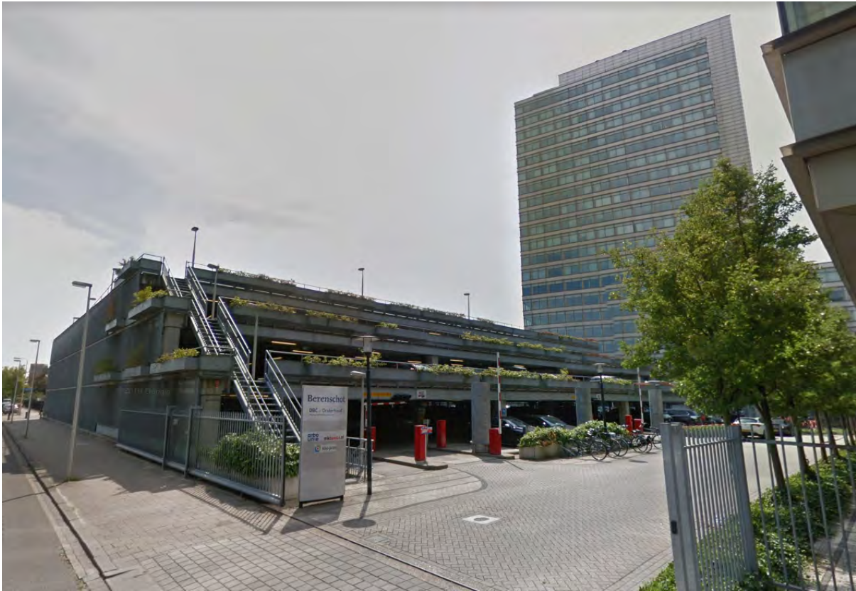
Overdekte parkeergarage op het achterliggende terrein behorende bij Beneluxlaan 1010 en Europalaan 40 (bron: Gemeente Utrecht, 2020)
