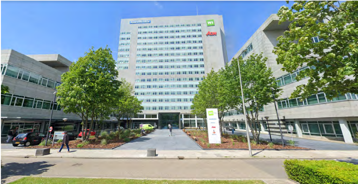
Zicht op ingang van het kantoor vanaf de Eendrachtlaan (bron: Google Streetview, 2019)
