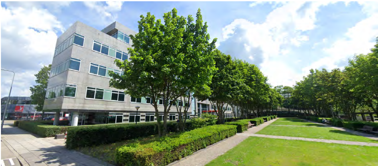
Zicht op kantoor vanaf Eendrachtlaan (bron: Google Streetview, 2019)
