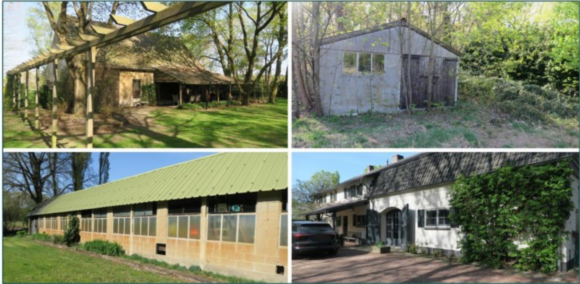
Figuur 2.3 Fotografische impressie van de te slopen bebouwing op de planlocatie.
