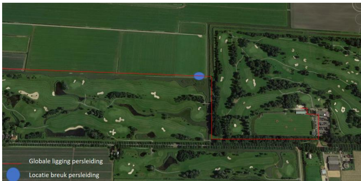
Figuur 3. Ligging persleiding op en nabij stortplaats, inclusief lekkage 2023
