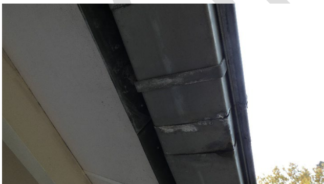
Foto 15: zinkwerk goten heeft aandacht, enige lekkage sporen op de aanhechtingen
