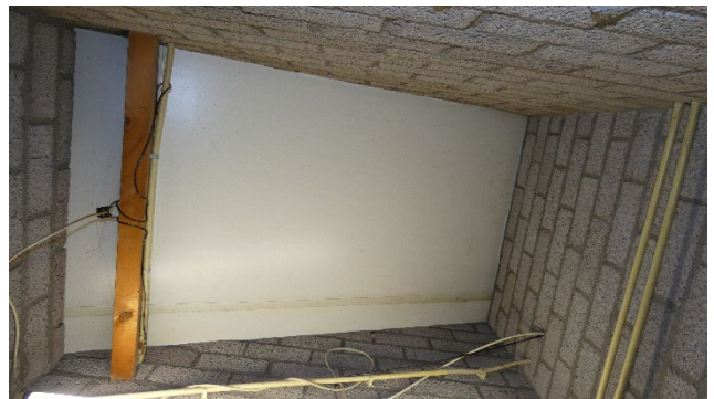
Foto 26: dakisolatieplaten met daarop golfplaat
