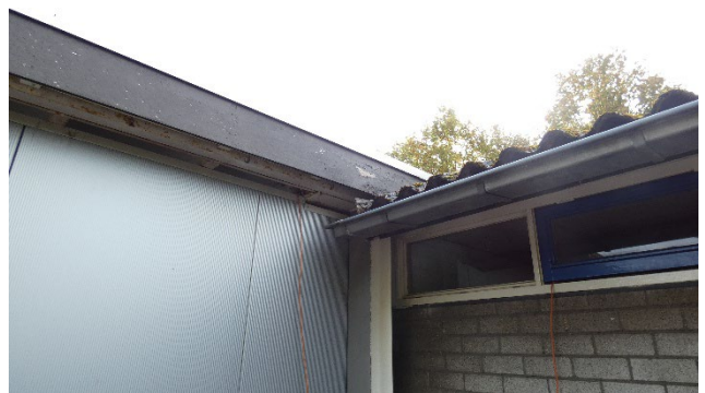
Foto 16: enkele houten boeidelen aan vervanging toe
