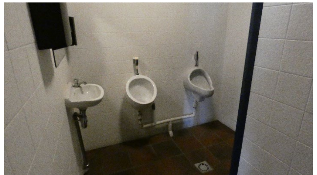
Foto 24: sanitaire ruimte (D en H)
