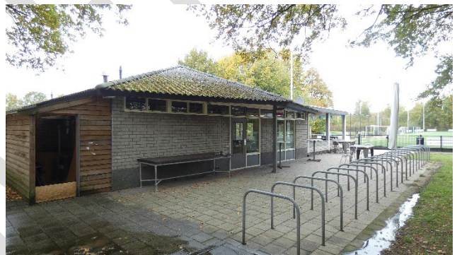
Foto 30: zijgevel kantine met fietsrekken
