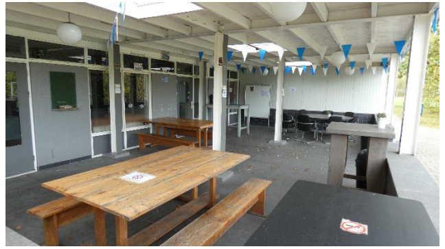
Foto 18: aangebouwd, bouwjaar onbekend
