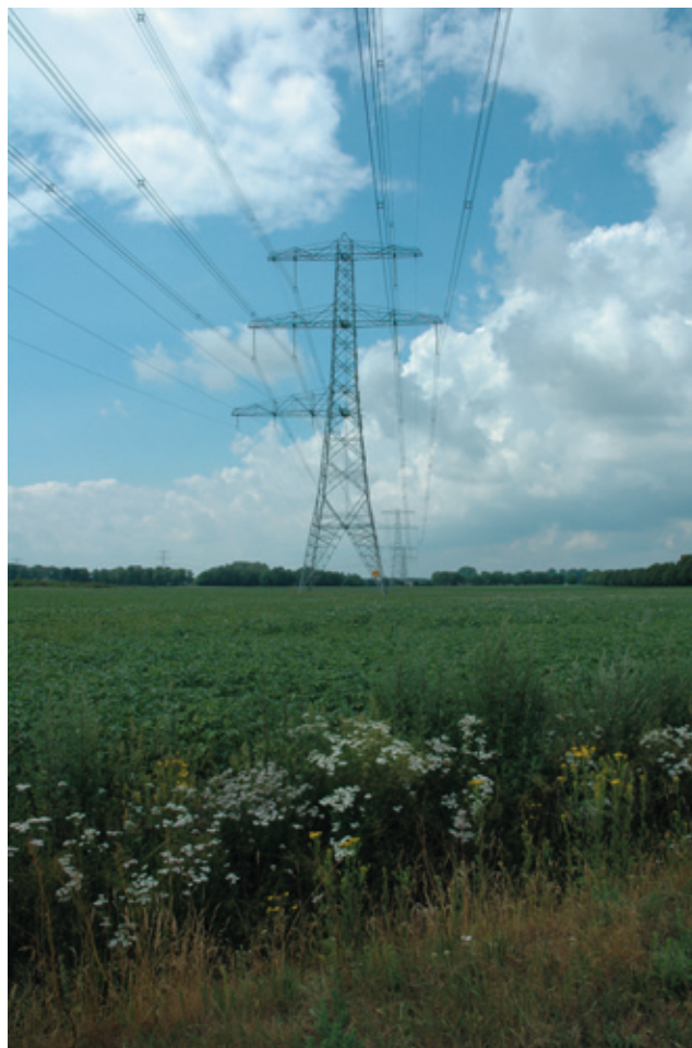
Afb. 68 Hoogteverschil zichtbaar door hoogspanningsleiding
