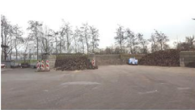
Afb. 03: foto verhard (klinkers) terrein met depot en keerwanden.
