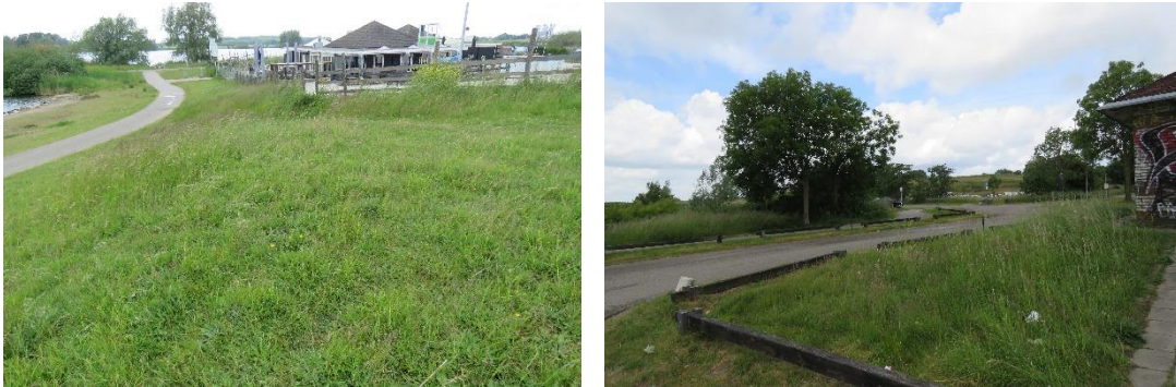
Figuur 3.1 Sfeerimpressie van het plangebied (foto's d.d.27 mei 2025). Linksboven de locatie van de nieuwe aanlegsteiger. Rechtsboven en -onder de locatie van het inkoopstation. De foto linksonder betreft de beoogde locatie voor het transformatorhuisje
