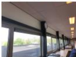
luchttoevoer met kleine raamroosters
