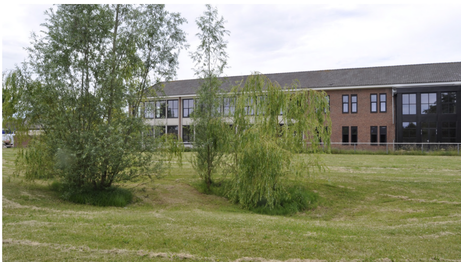
Afbeelding 51: wadi's voor de infiltratie van regenwater.
