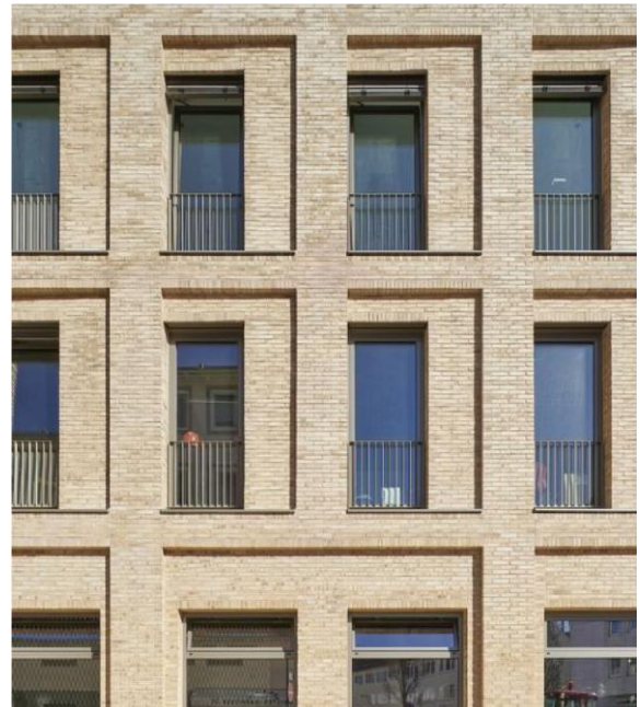
Dieptewerking en verticale geleding in de gevel (Am Marstall Hannover, pape+pape architecten)
