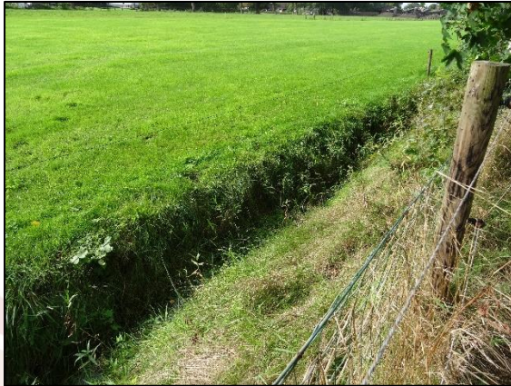
Fig. 2.4, Sloop aan zuidgrens van projectlocatie (bron: FF Solutions)
