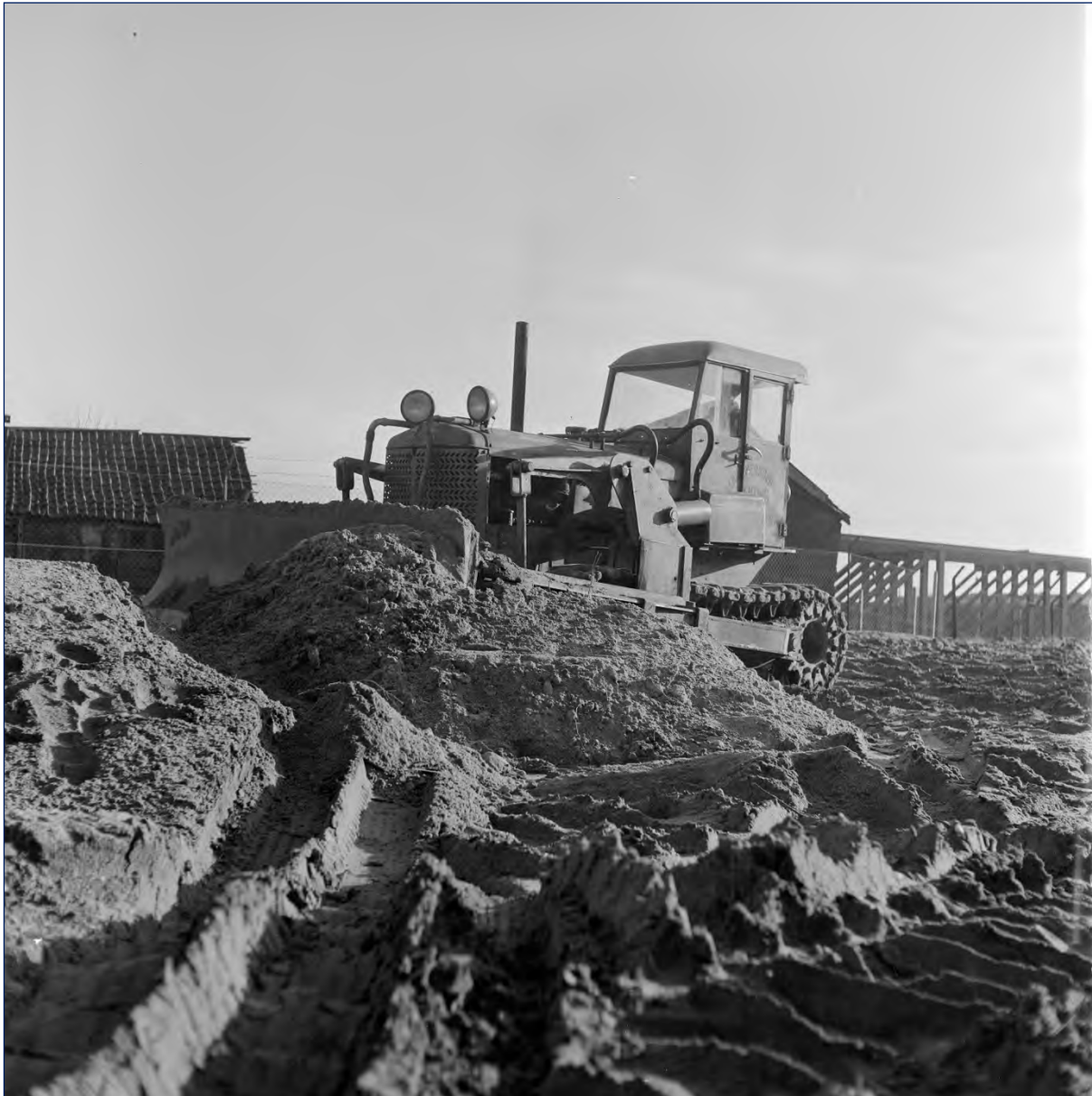
Figuur 14: Opspuiten van het AKZO terrein, 30-12-1953.
