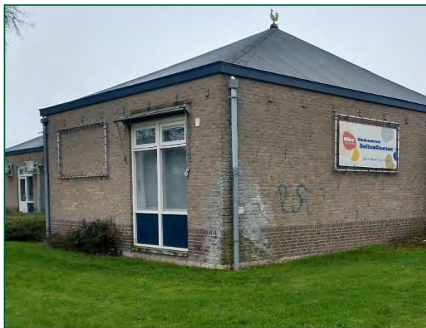
foto 8: een zijde van het kinderdagverblijf met dicht tegen de gevel een aantal bosshages. Er zijn geen scheuren of kieren aanwezig in de gevel
