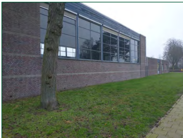
foto 2: Gymzaal bij het schoolgebouw met aan de bovenkant aftimmering
