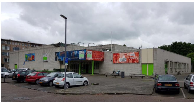
Figuur 4: Ingang school gezien vanaf het Stadhoudersplein
