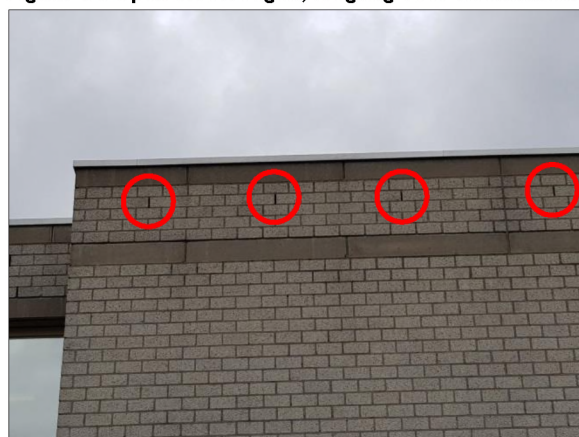
Figuur 12. Open stootvoegen, toegang voor vleermuizen
