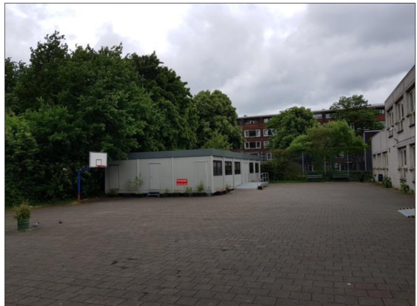
Figuur 6. Noodgebouw aan noordzijde GLR
