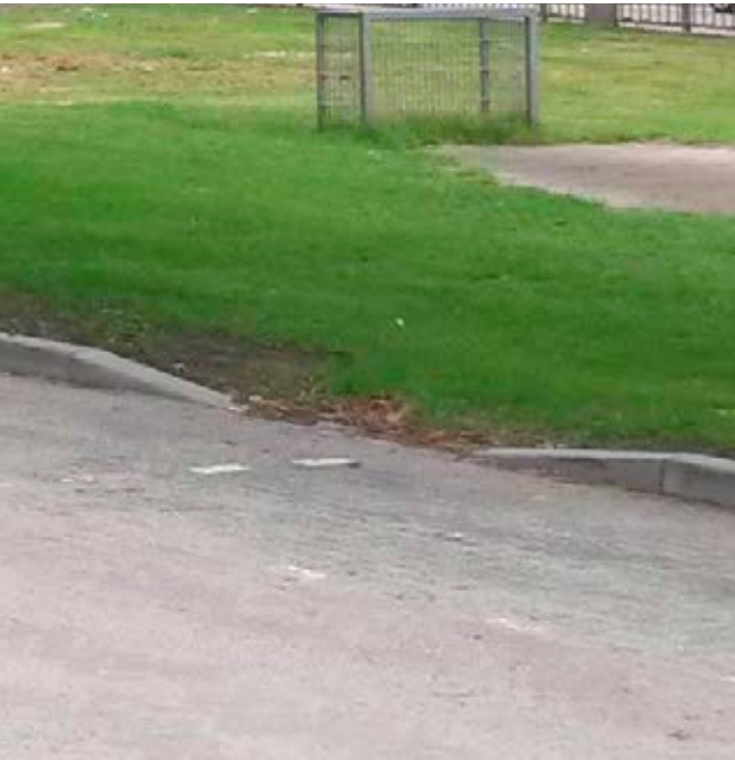
Molgoot langs de weg met verlaging in opsluitband
