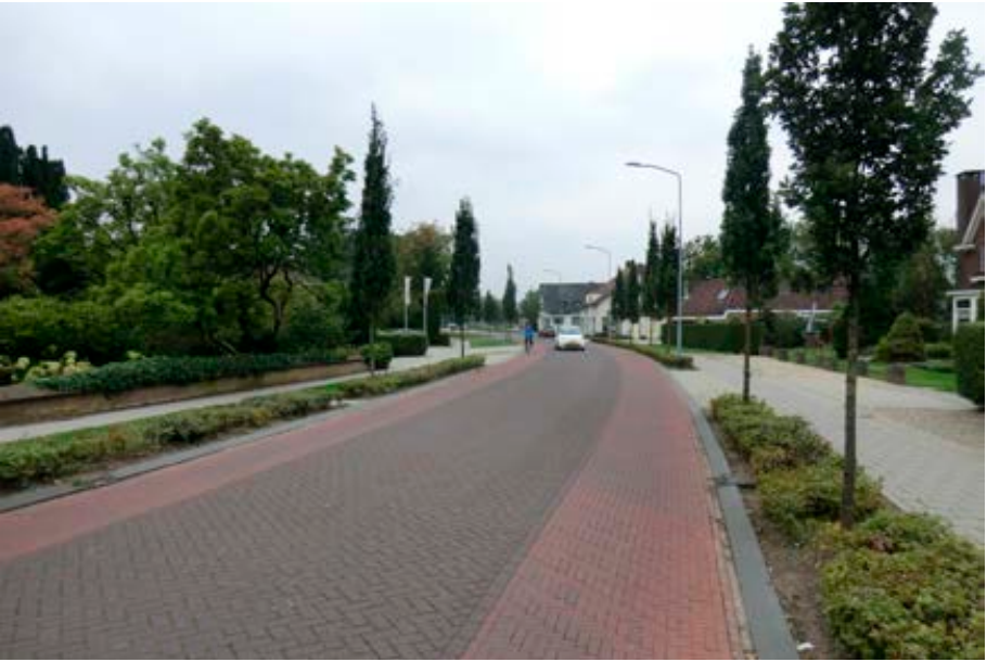
Westelijke reeds heringericht deel van de Rijksweg
