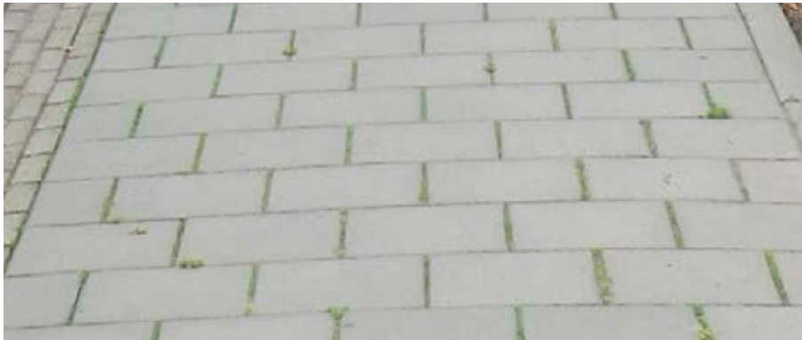
betontegel, 30x30, halfsteensverband
