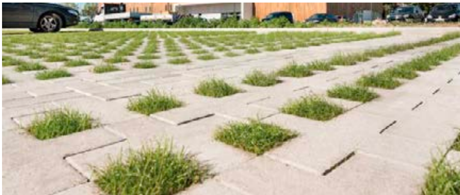
Greenbricks gecombineerd met betonstraatstenen, keifmaat, elleboogverband, roodbruin
