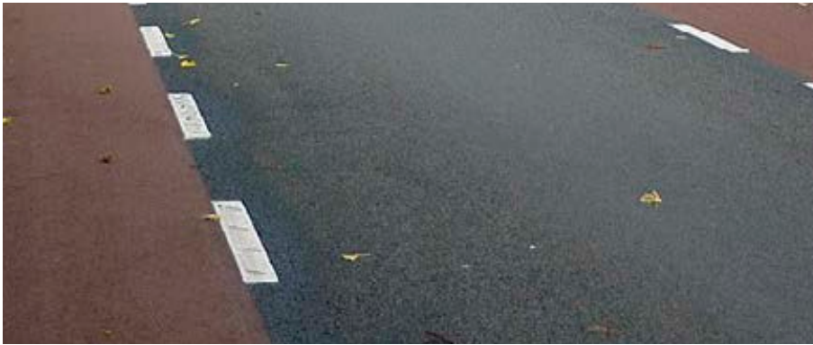
asfaltverharding met witte onderbroken belijning tussen fietsstrook en rijbaan
