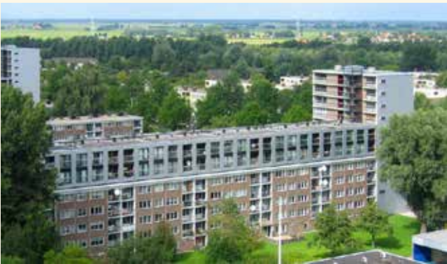
Optoppen van bestaande flats
