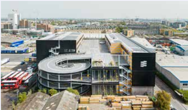
Meerlaagse bedrijfsgebouwen met slimme logistieke- en parkeeroplossingen
