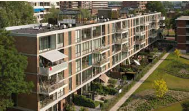
Aan- en verbouwen van bestaande flats
