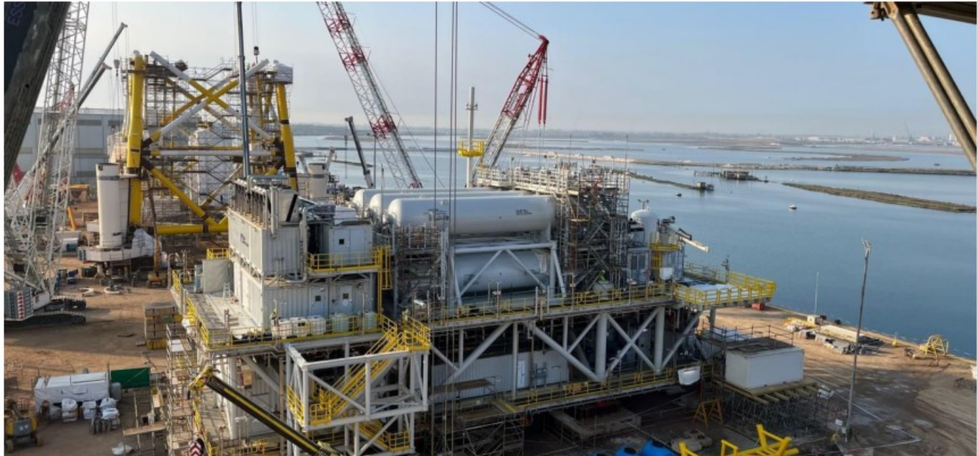
CrossWind BLBH, een joint-venture van Shell en Eneco.
