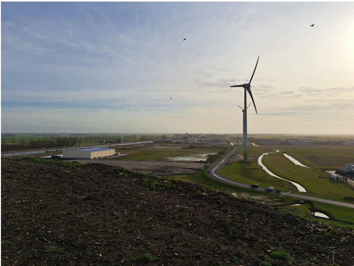
Foto 4: Lijnopstelling van windturbines in zuidelijke richting.
